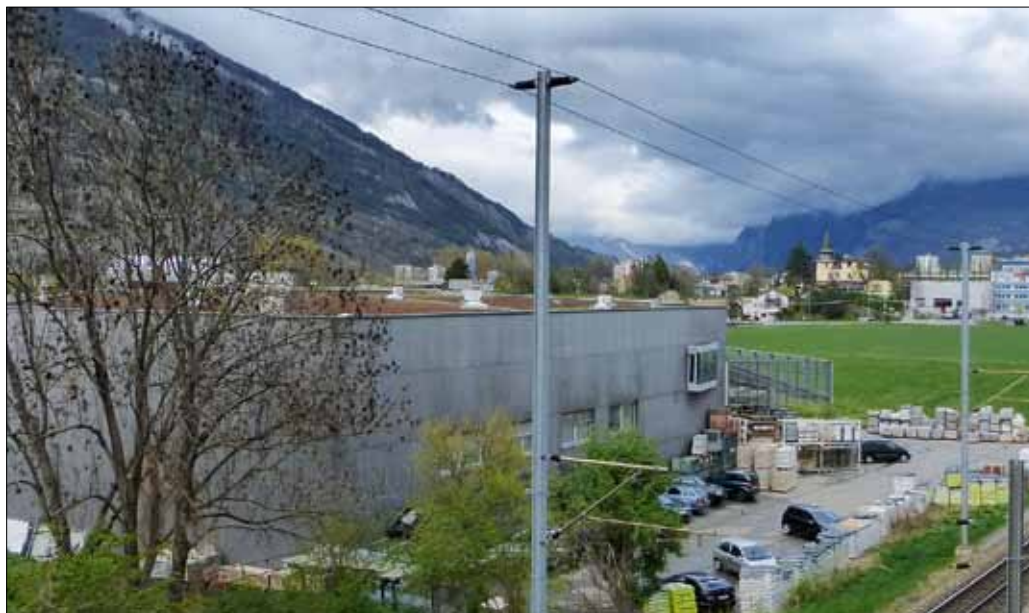
Blick nach Chur-West: Werden hier preisgünstige Wohnungen entstehen?
