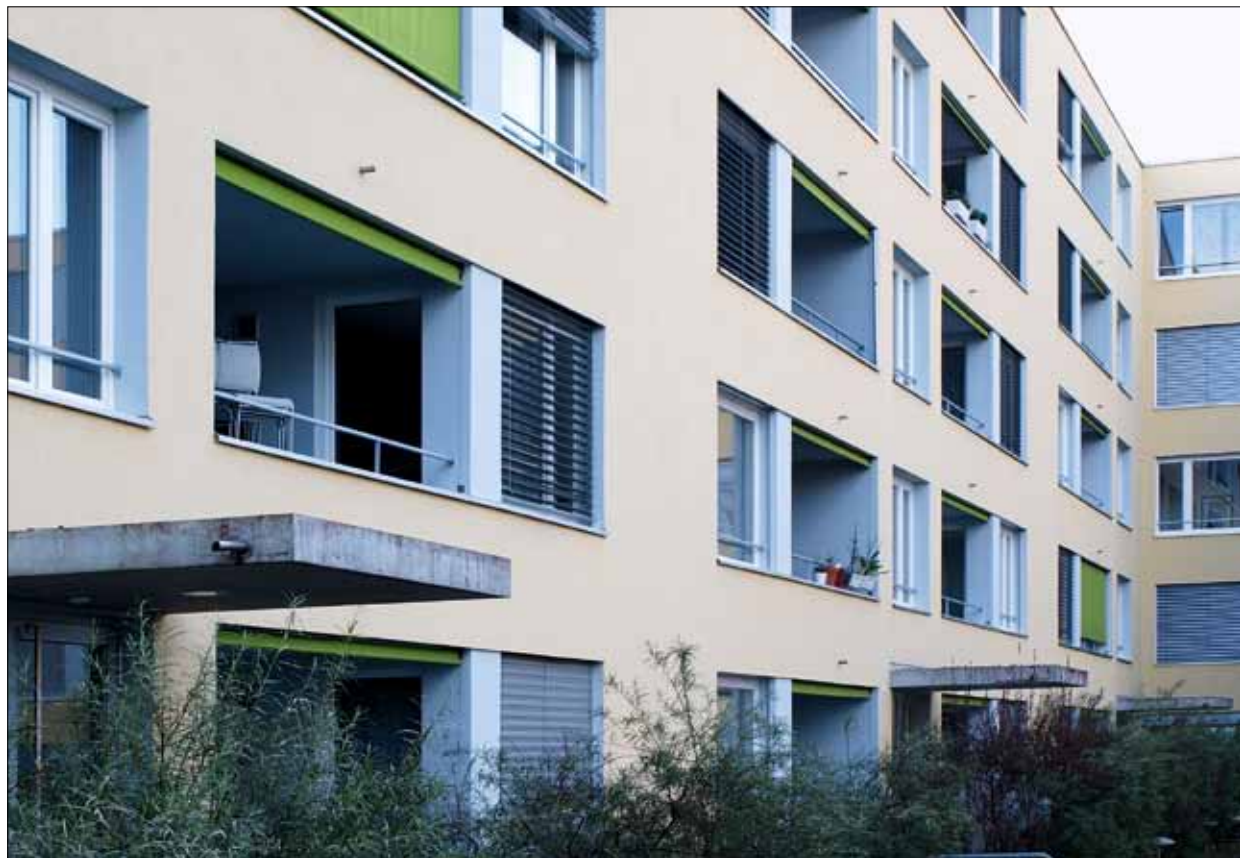
Dieses Wohnhaus in Kaiseraugst wurde den künftigen Mieterinnen und Mietern mit Minergie angepriesen. Doch es war gar keine Minergie drin.
