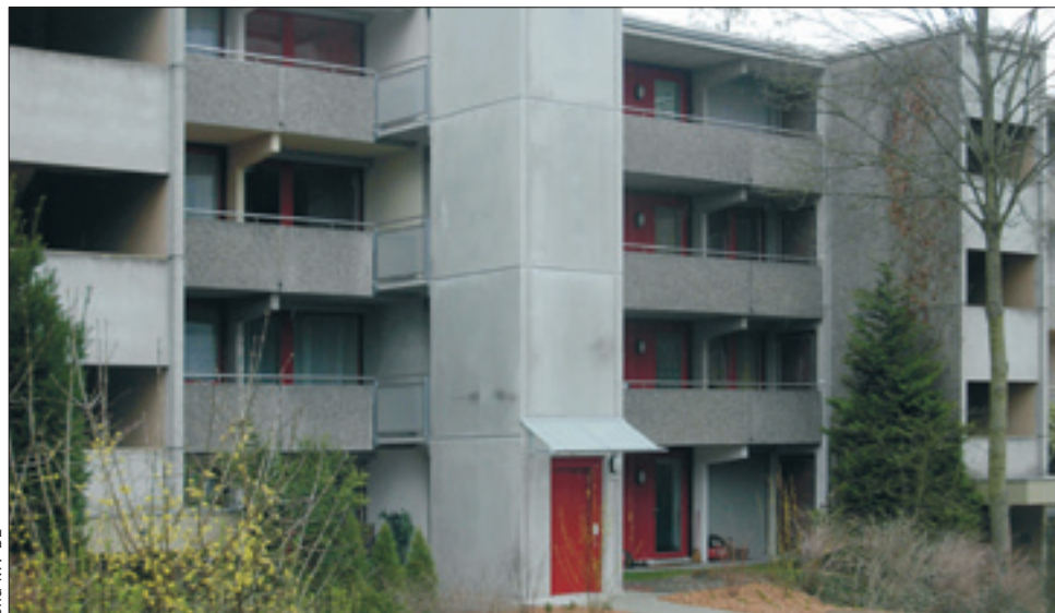
Mit einem solchen Liftanbau gewinnt der Architekt kaum einen Preis.
