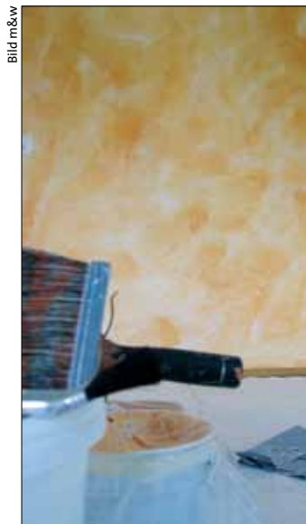
Ein neuer Wandanstrich ist nach 8 bis 10 Jahren fällig.
