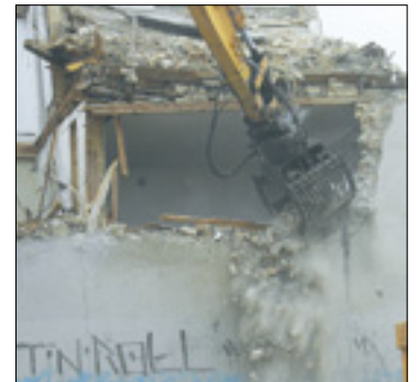
Streichet Basel den Abbruchschutz?
