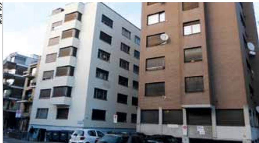
Diesmal richtig: die beiden vernachlässigten Wohnhäuser an der Neufrankengasse in Zürich. In M&W 8/2015 hatten wir teils ein falsches Objekt abgebildet. Wir bitten das Versehen zu entschuldigen.
