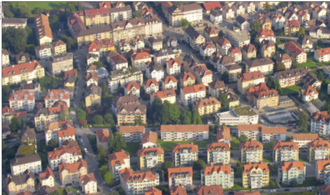
Was sind orts- und quartierübliche Mieten? Diese Frage spielt vor Gericht oft eine Rolle.
